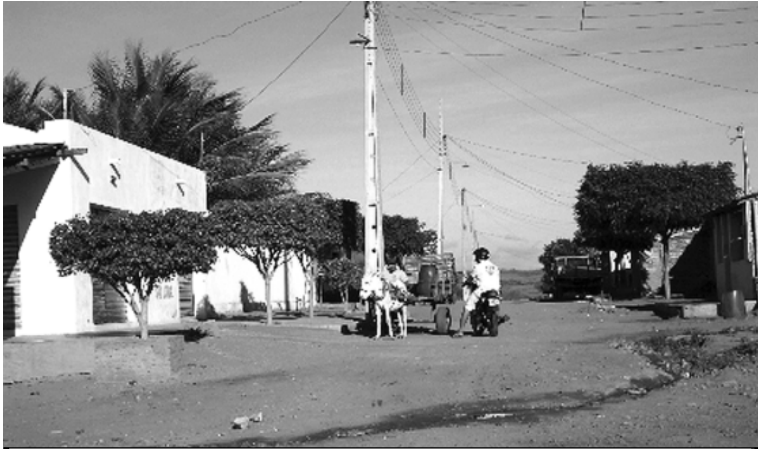
A obra faz parte das exigências do Projeto de Transposição das Águas do Rio São Francisco e após conclusão o bairro será pavimentado
